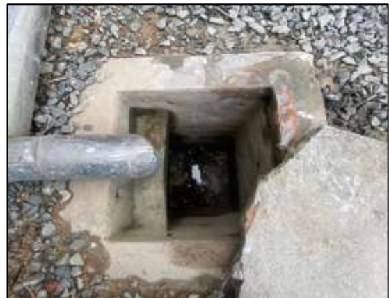
ระบบระบายน้ำฝนจากหลังคาลงสู่บ่อพัก
